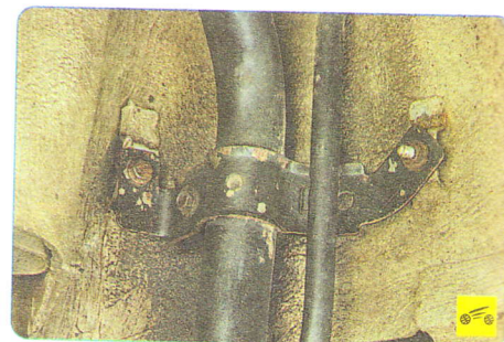
11. Вывернув болт и отвернув гайку крепления верхних кронштейнов наливной трубы...
